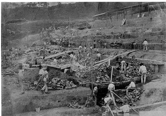
Figura 8.35 – Construção da nova planta (1886-1892). Fonte: Arquivo Anglogold
